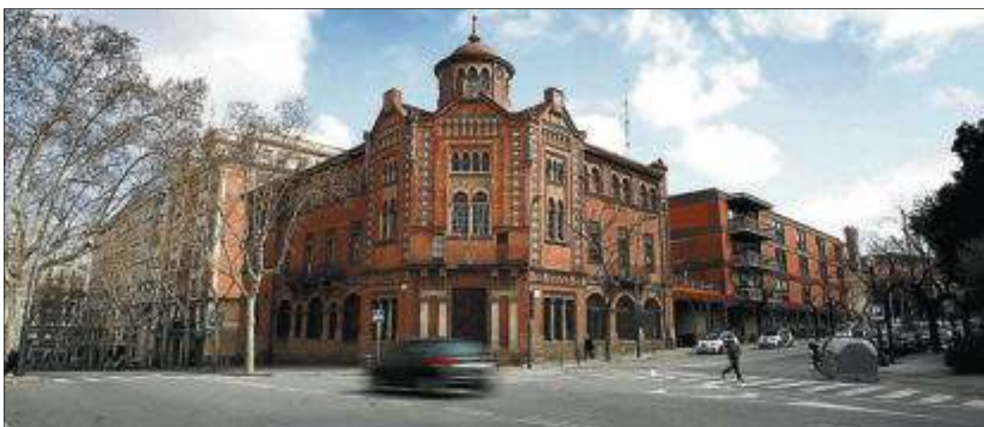
La Casa de la Prensa, construida por Pere Domènech, que acogerá en 2013 el nuevo museo. / JOAN SÁNCHEZ
